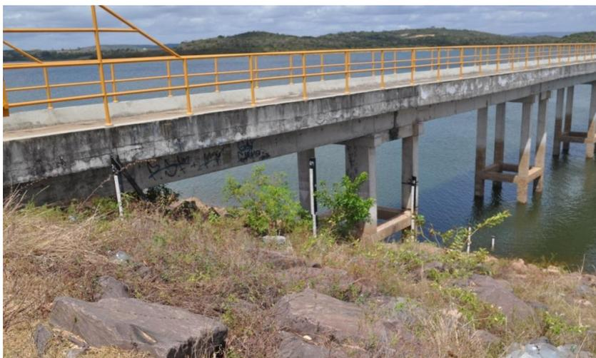
**Figura 3.** Lance de réguas limnimétricas para determinação do volume Acumulado na barragem Jaime Umbelino de Souza (Poxim)
