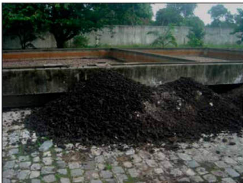
Figura 90: Lodo desidratado e desinfetado. ETE Orlando Dantas – Aracaju. Foto: M&C Engenharia/2013.
