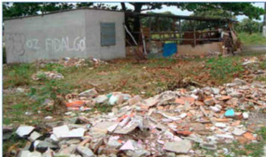
Figura 52: RCD: entulho de obra – Nossa Senhora do Socorro/SE. Foto: M&C Engenharia (2012).
