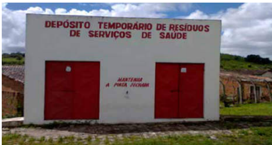
Figura 101: Abrigo temporário de RSS – Laranjeiras/SE.
