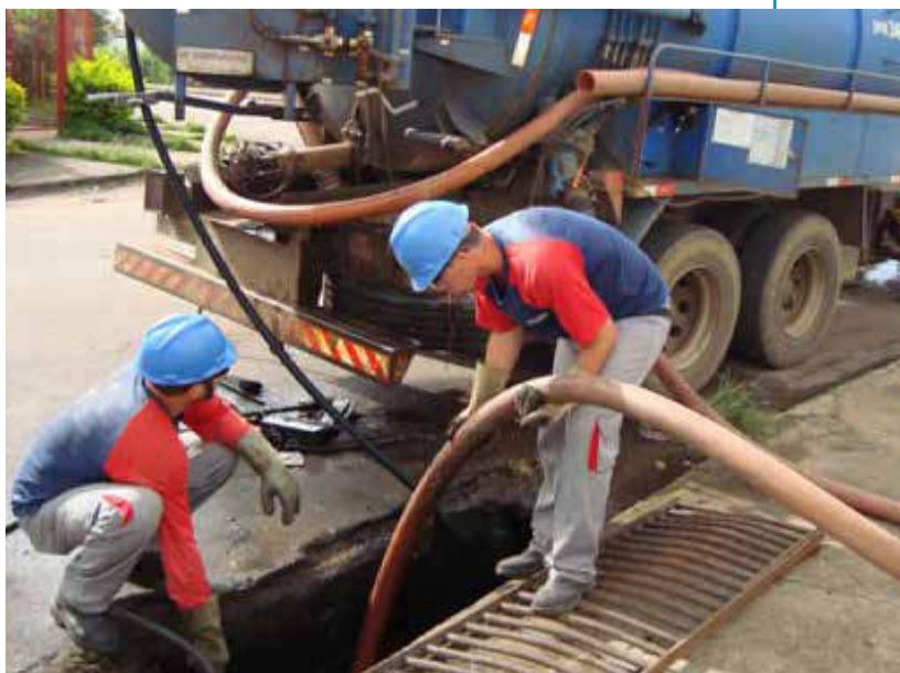
Figura 48: RSPSB: limpeza do sistema de drenagem.
