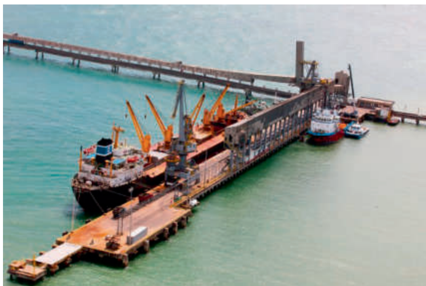
Figura 104: Ponte de acesso ao retroporto e o cais de acostagem do TMIB.
