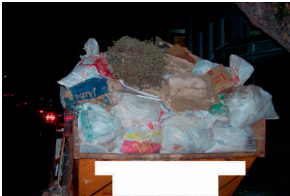
Figura 84: Caçamba Estacionária em via pública com resíduo distintos a classe A do RCD. acondicionamento inadequado. Elaboração: M&C Engenharia, 2016.
