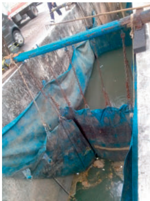
Figura 31: RSPSB – Limpeza de canal pelo método “barragem móvel” – Aracaju/SE
