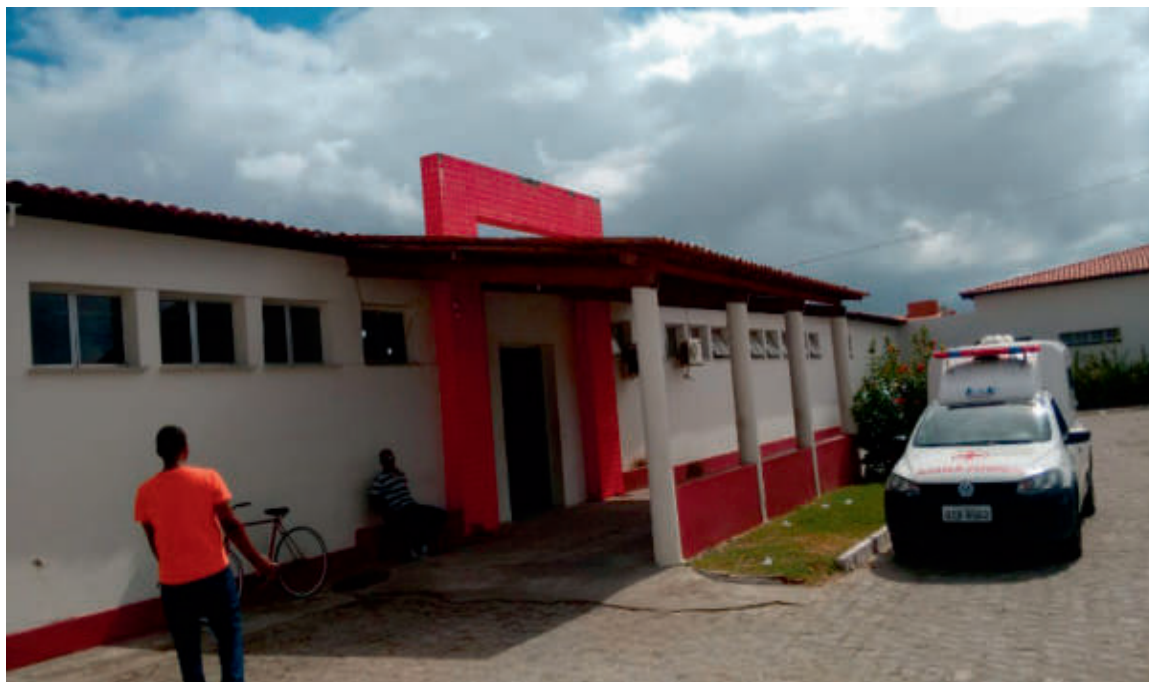
Figura 73: Unidade de atenção básica de saúde da Barra dos Coqueiros/SE Crédito da foto: M&C Engenharia (2015)
