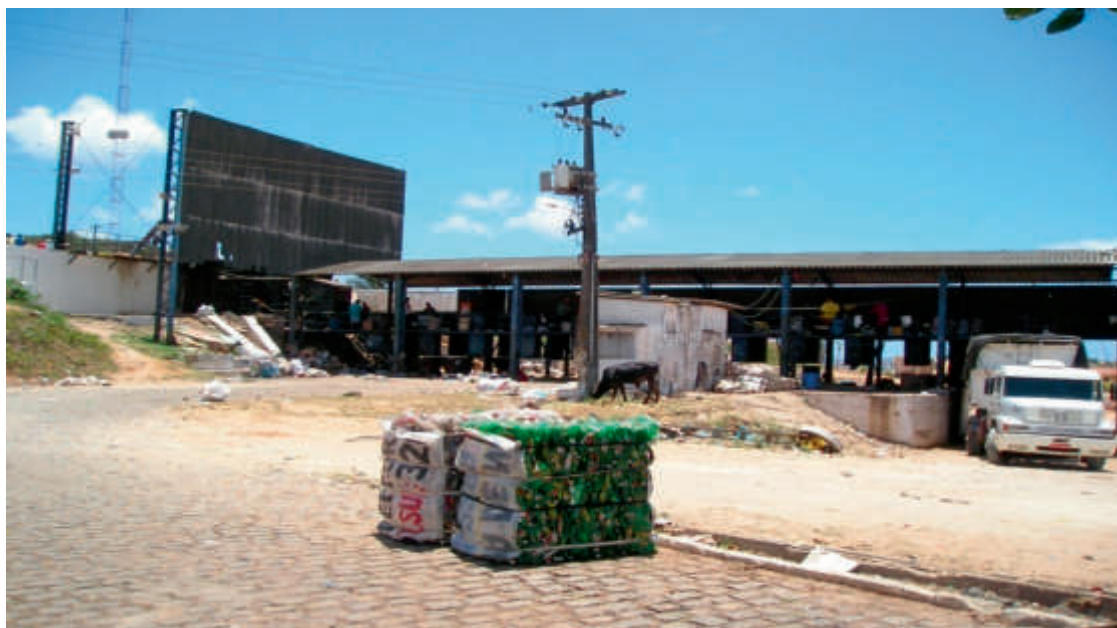
Figura 128: Área de triagem de uma estação de transbordo, em Natal - Rio Grande do Norte, 2006.
