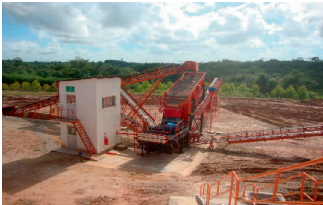
Figura 96: Complexo de britadores de mandíbula do Polo de Gerenciamento de Resíduos Itacanema.
