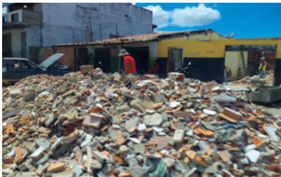
Figura 40: RCD: entulho de obra – Tobias Barreto/SE.
