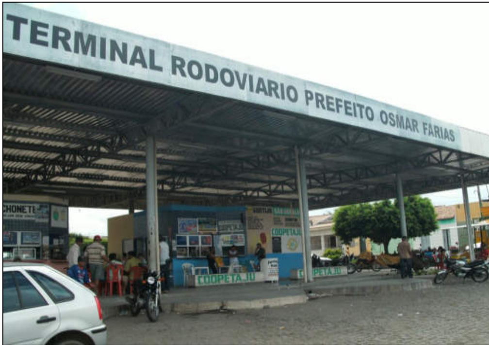
Figura 38: Terminal rodoviário – Monte Alegre de Sergipe/SE.
