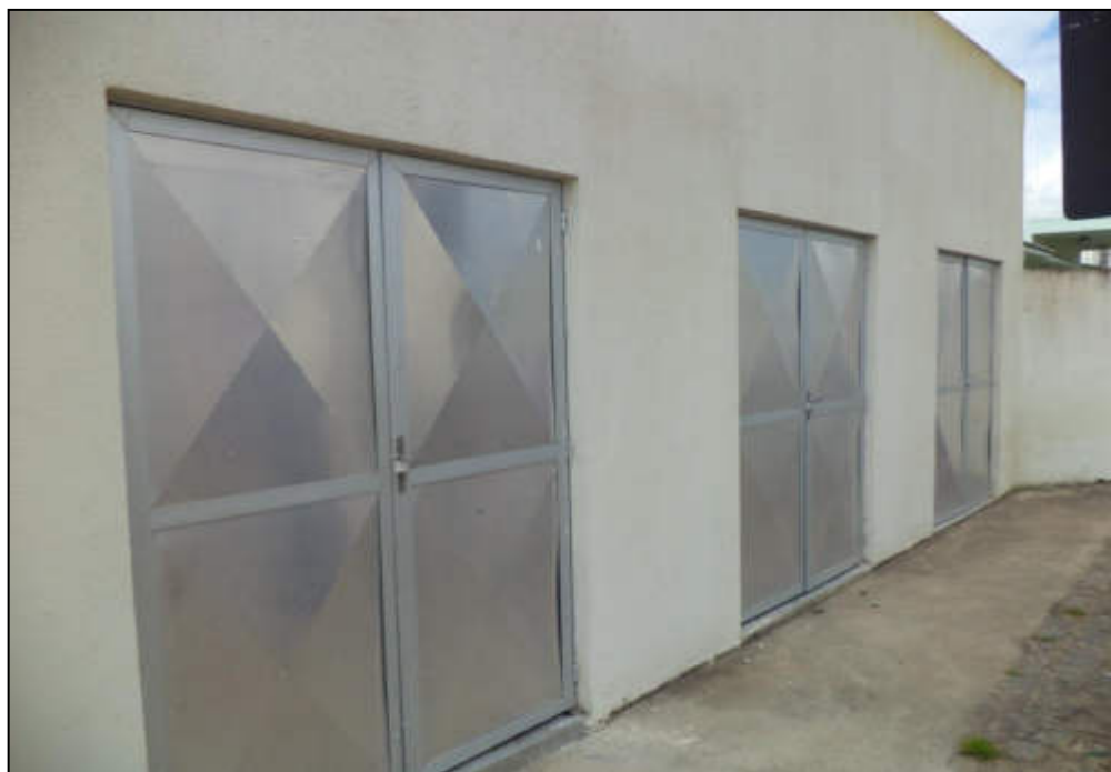
Figura 63: Abrigo temporário de RSS com três compartimentos – Itabaiana/SE. Crédito fotográfico: M&C Engenharia/2013.
