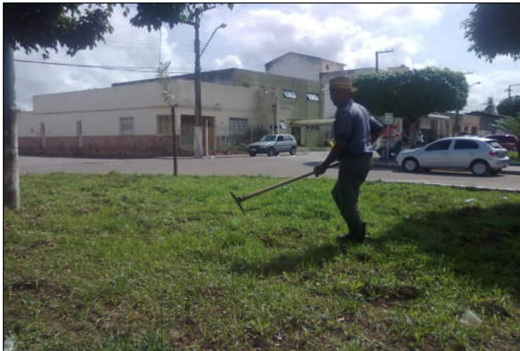
Figura 49: Serviço de capina manual – Moita Bonita/SE. Crédito da foto: M&C Engenharia/2013.
