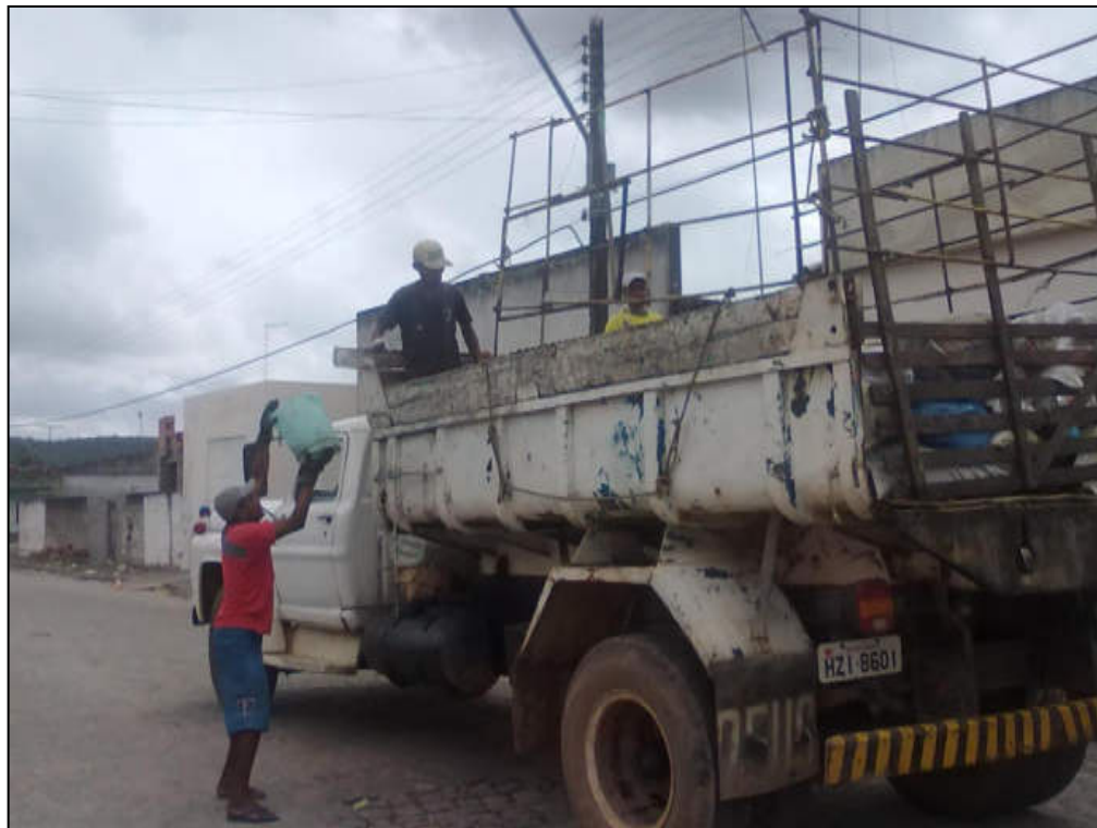
Figura 38: Caminhão basculante – Moita Bonita/SE. Crédito da foto: M&C Engenharia/2013.
