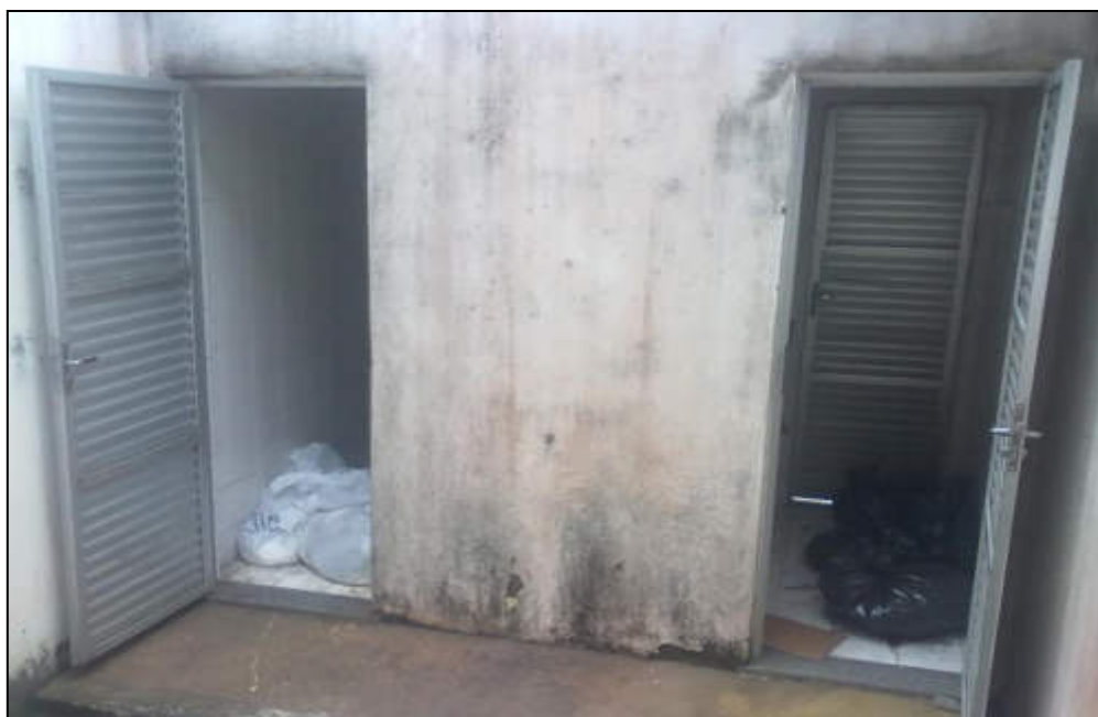
Figura 29: Abrigo de RSS perigosos e comuns– Malhador/SE.
