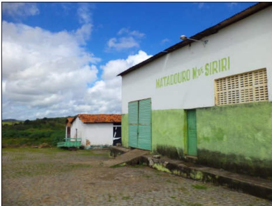
Figura 32: Matadouro – Siriri/SE. Crédito fotográfico: M&C Engenharia/2013.
