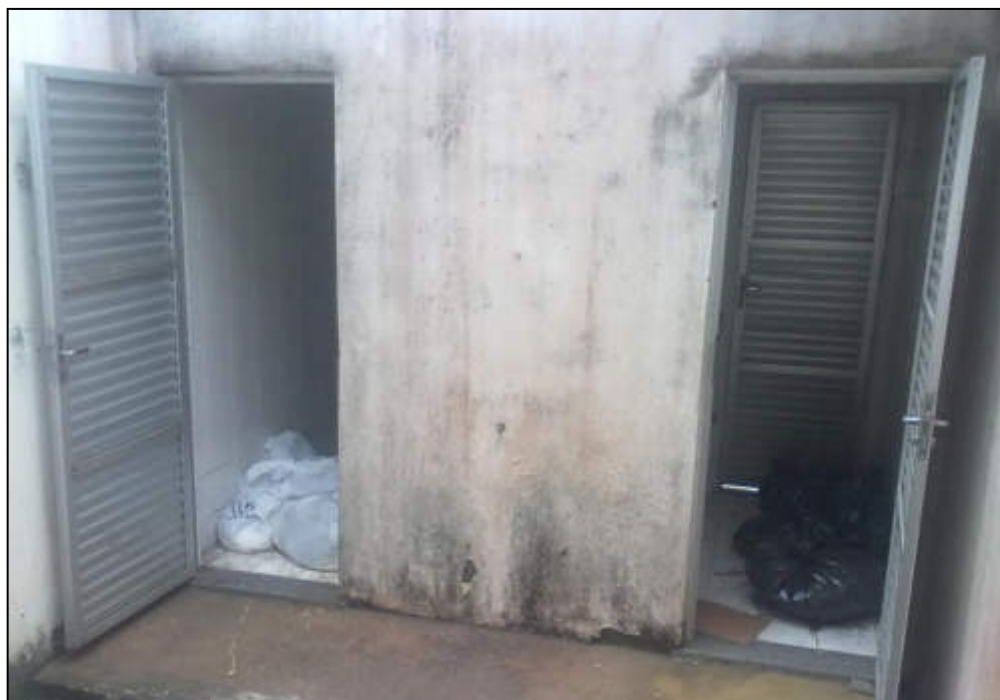
Figura 67: Abrigo temporário de RSS com dois compartimentos – Malhador/SE. Crédito fotográfico: M&C Engenharia/2013.
